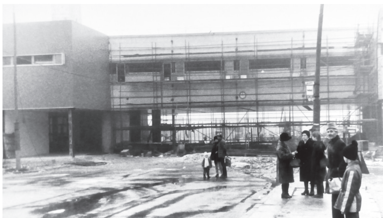
Stavba Kultúrneho domu na Ovsíšťskom námestí.
